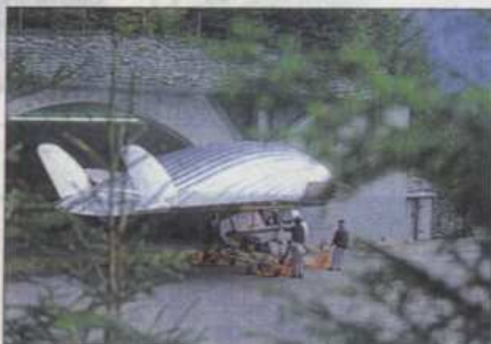
Unter dem Flugkörper wird die Pilotenkabine montiert.
